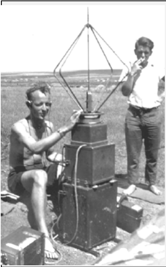
Portabel närfältspejl typ Kapch- Nahfeld- Peiler tillsammans med en Funk HE U1 närfältspejl.
