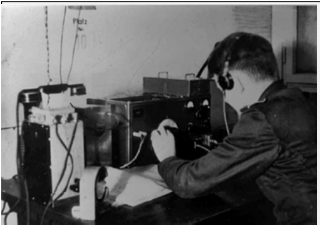
På denna bild visas en Siemens mottagare typ R IV, som skilde sej från KST-mottagaren genom att de utbytbara spolarna var monterade på
