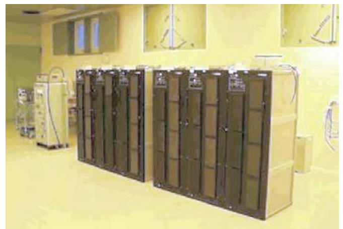
Bild 6. Rockwell-Collins PA-2250 effektsteg
