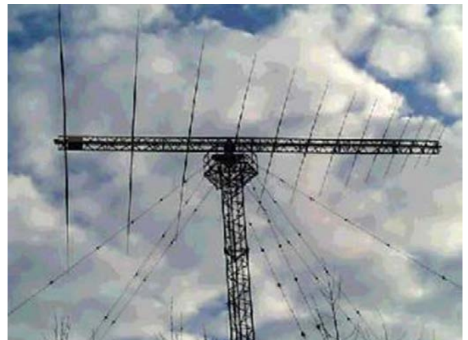
Bild 5. Telefunken 5,2 – 30 MHz vridbar logperiodisk antenn
