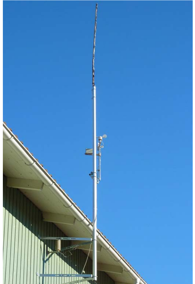
Bild 5: N9TAX Slim-Jim-antenn monterad i toppen på 3 meter maströr.
