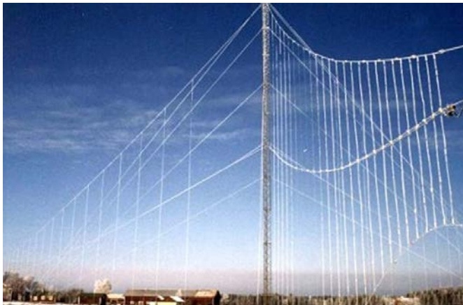
Bild 8. TCI vertikalt polariserat log-periodiskt antensystem vid Enköping Radio
