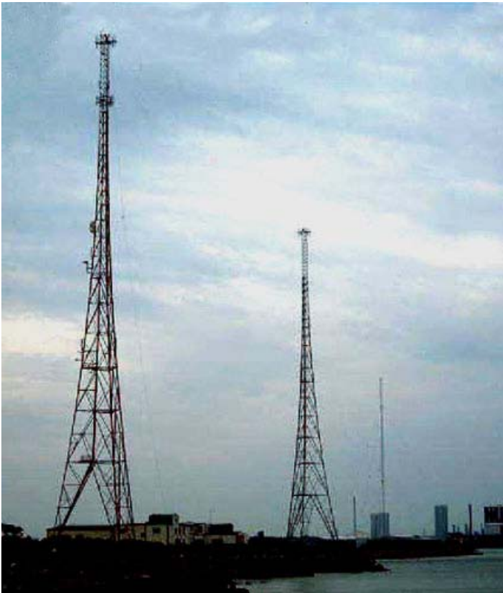
Masterna efter ombyggnaden.
