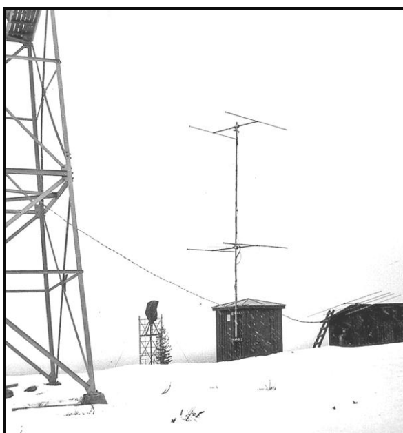
Brandtornet tv i vars topp en antenn liknade den som den som syns på det lilla apparatusets tak var monterad. På den lilla "masten" sitter TV-länken mot Skellefteå.
