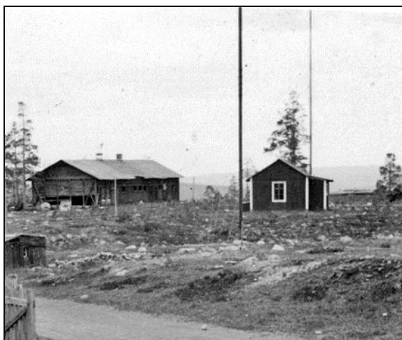
Radiostationen med sina två ca 60 m höga trä- master var och en gjord av tre trästolpar. Den första sändaren i Malmberget.
